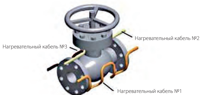
Обмотка задвижки нагревательными кабелями
